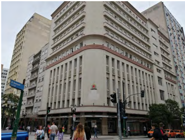
Figura 5: Antigo edifício do Clube Curitibano, esquina da Rua XV de Novembro com Barão do Rio Branco, onde funcionou temporariamente no 6º andar a AEAPR.
